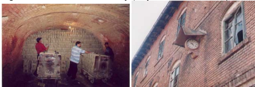
Fig. 2. Fabrica de cărămizi Ciurea Iași (aranjarea cărămizilor în cuptor, fațada clădirii cu ceas Paul Garnier).
